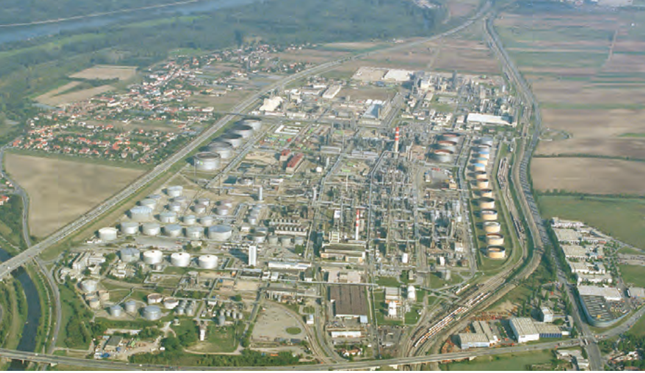
Blick auf die Verfahransanlagen der Raffinerie Schwechat heute
